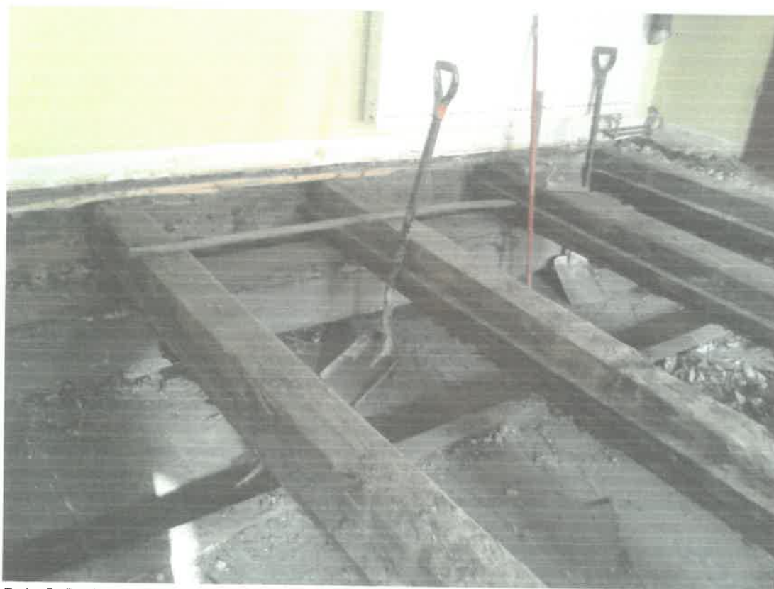
Fot. 3 Podciąg drewniany 18x 28 cm. Element nie wykazuje nadmiernego ugięcia. Brak widocznych uszkodzeń, element wykazuje poprawą pracę statyczną.
