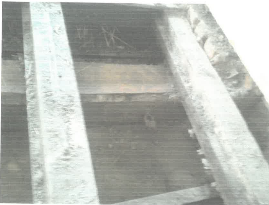
Fot. 3 Podciąg drewniany 18x 28 cm. Brak widocznych oznak korozji oraz innych uszkodzeń, element wykazuje poprawą pracę statyczną.
